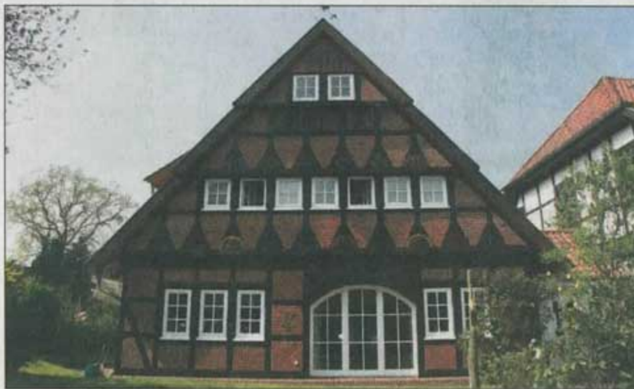
Der Fachbetrieb Plinke GmbH Zimmerei & Bedachungen hat sich Fachwerksanierung, Holzrahmen- und Fachwerkbau spezialisiert. Foto: Petra Plinke
